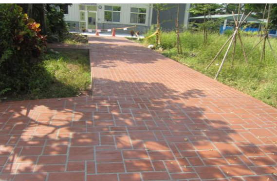
(d) The JW pavement
